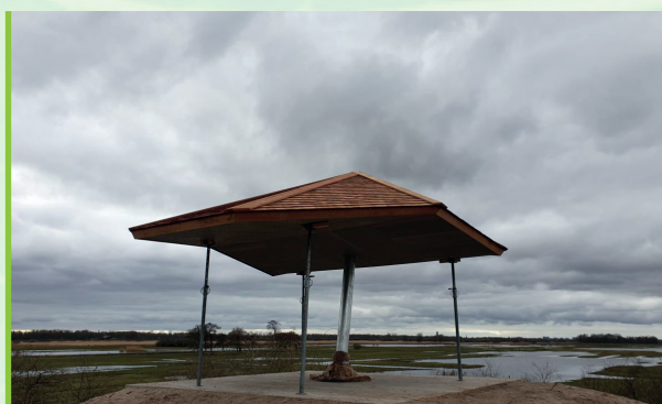
Uitkijkpunt Ryptsjerksterpolder in aanbouw
